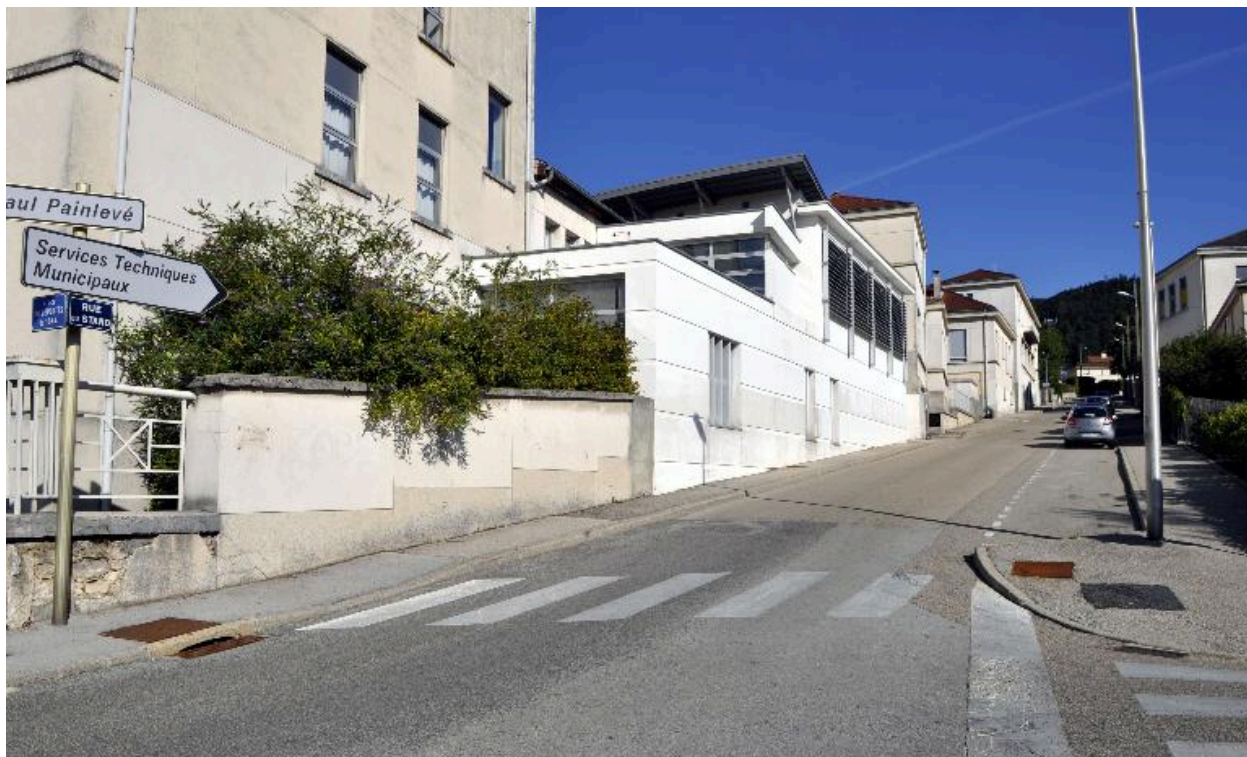
Elévations latérales sud-est, depuis l'est
