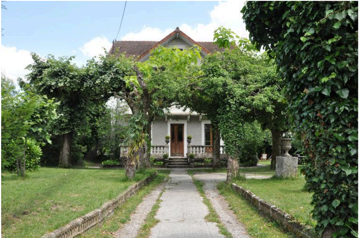
Façade principale et jardin
