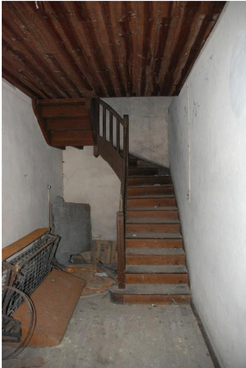
Vue intérieure du rez-de-chaussée : vestibule, escalier principal.
