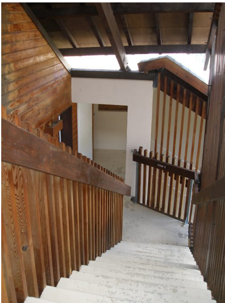
Vue d'un escalier
