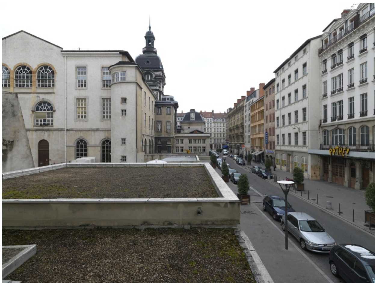
La rue Bellecordière depuis la terrasse à l'arrière du bâtiment J, au nord
