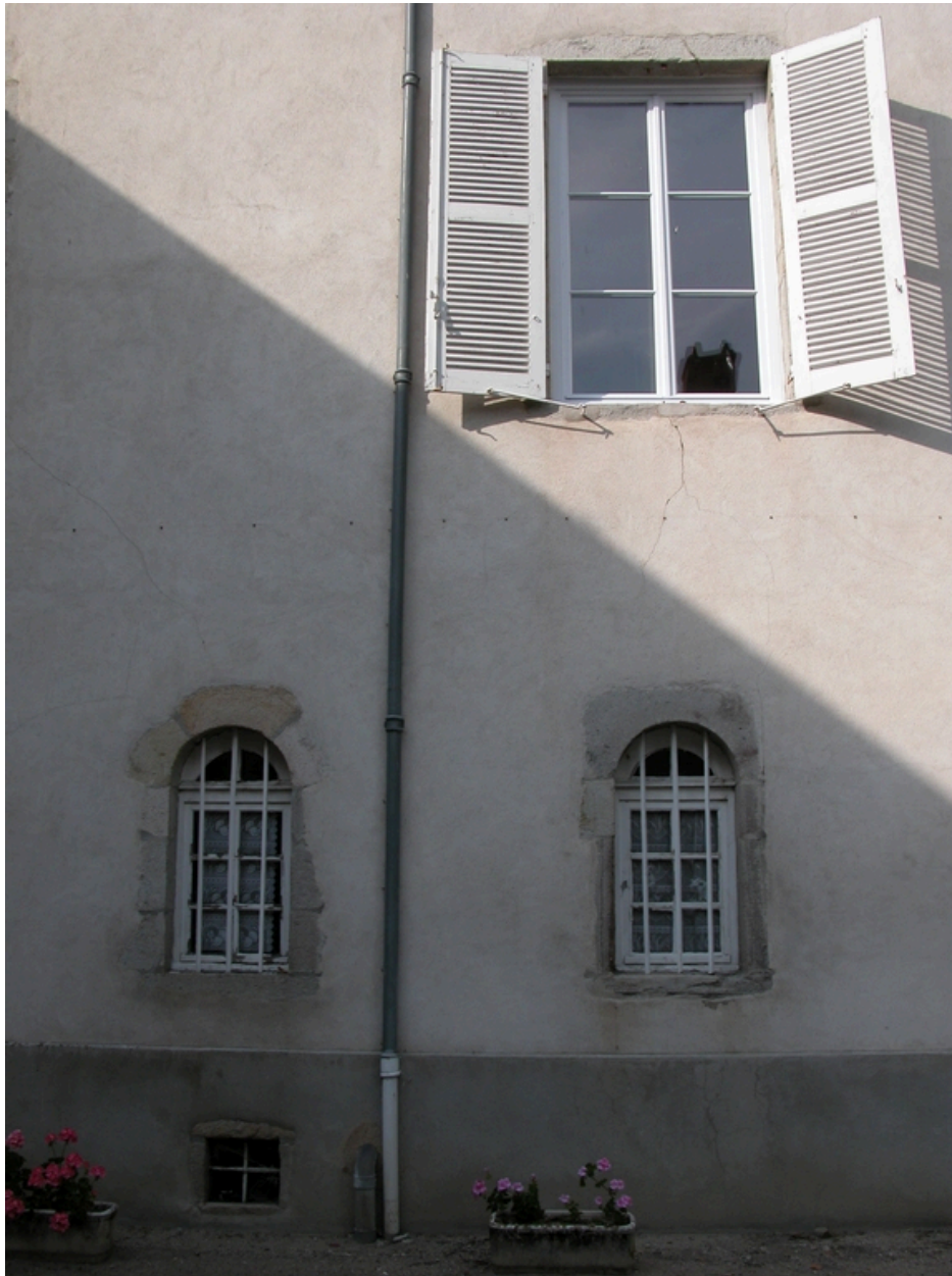
Détail des fenêtres en plein cintre au rez-de-chaussée de l'aile nord, sur cour.
