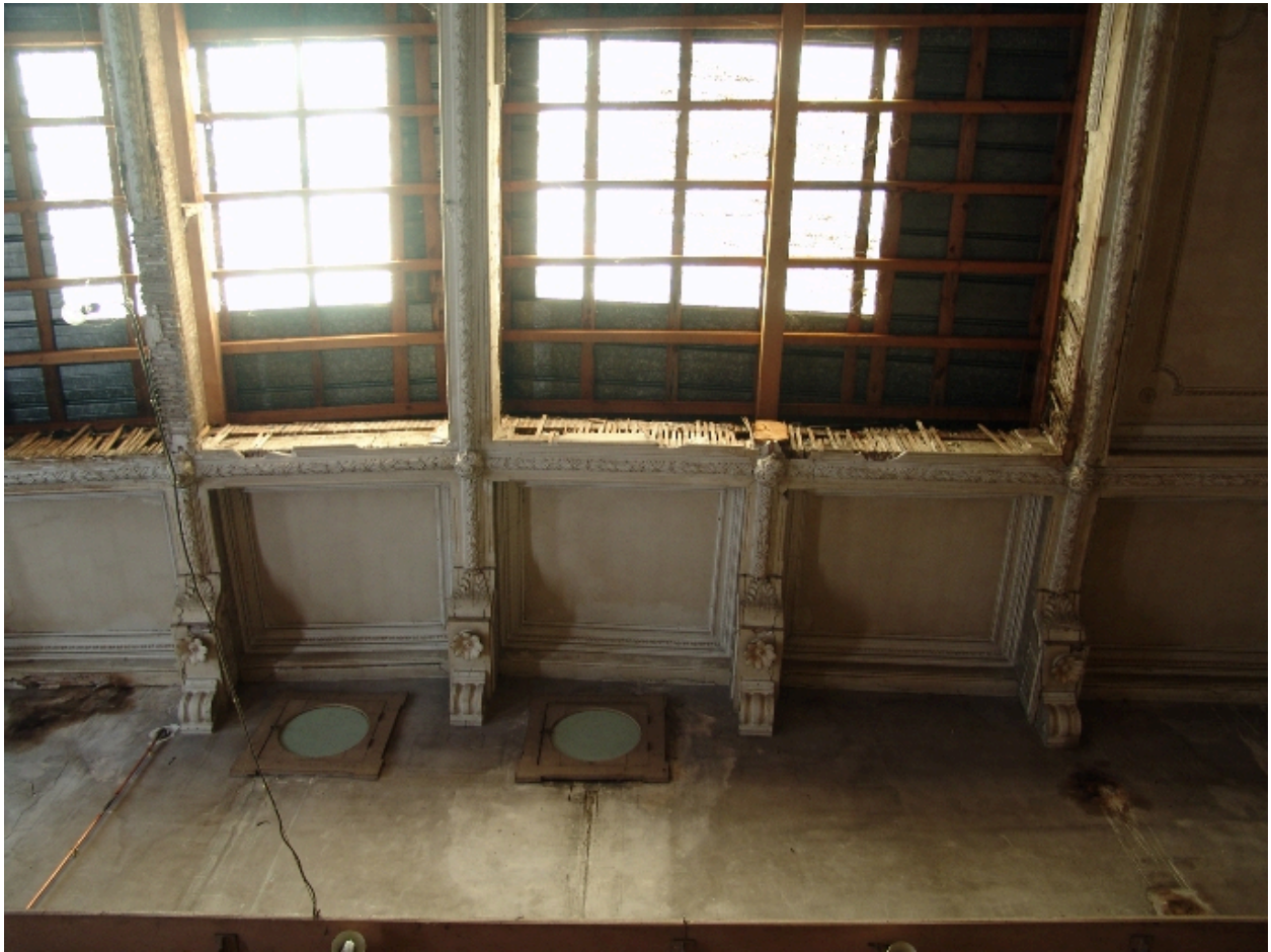
Plafond à décor de stuc et verrière zénithale
