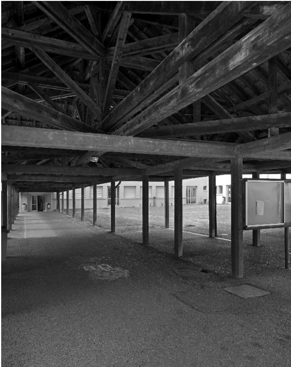
Préau, détail de la charpente
