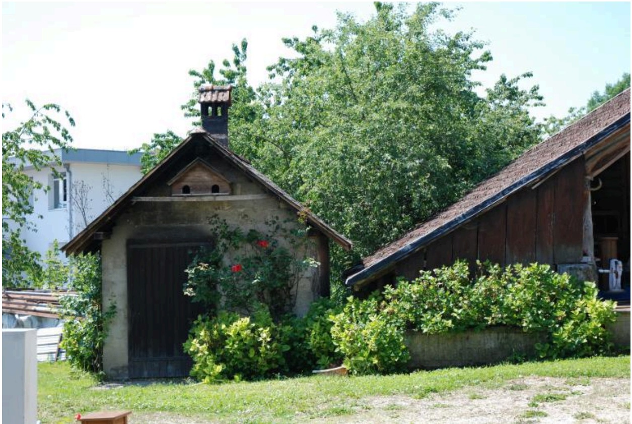
Vue du four à pain.
