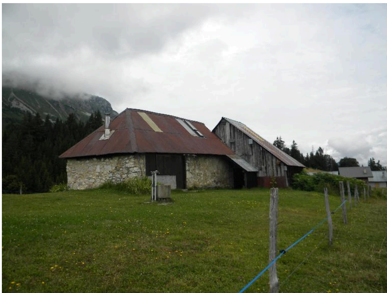
Vue de trois-quarts sud-est de l'étable sud.
