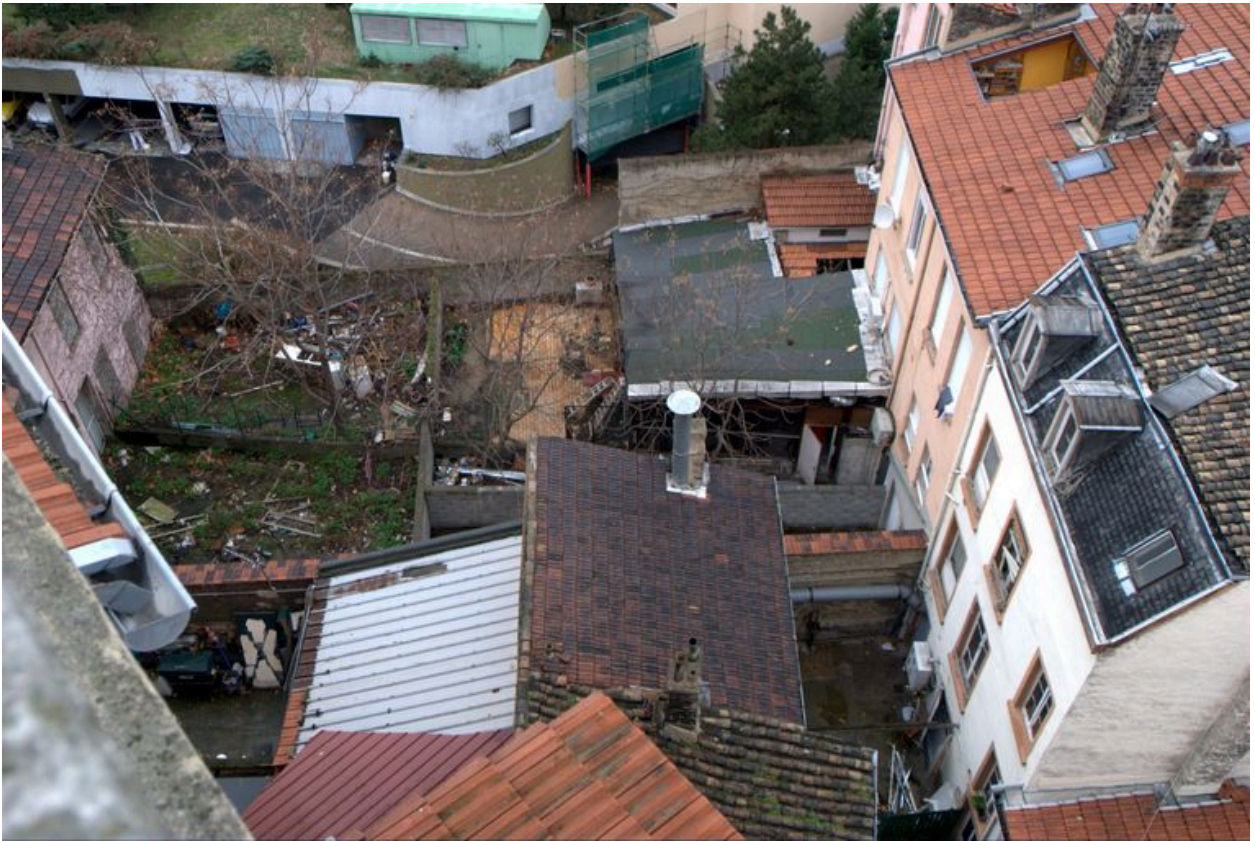
Elévation postérieure et cour depuis le toit du 67 rue Domer au sud
