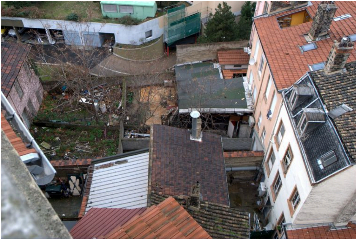
Élévation postérieure et cour depuis le toit du 67 rue Domer au sud
