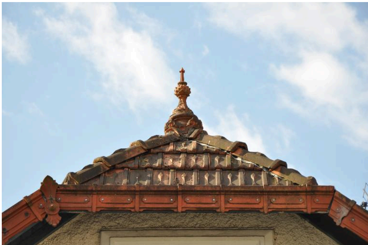
Détail de l'épis de faîtage
