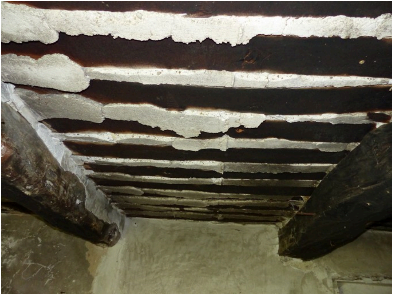
Second étage de soubassement, cuisine. Détail du plafond.
