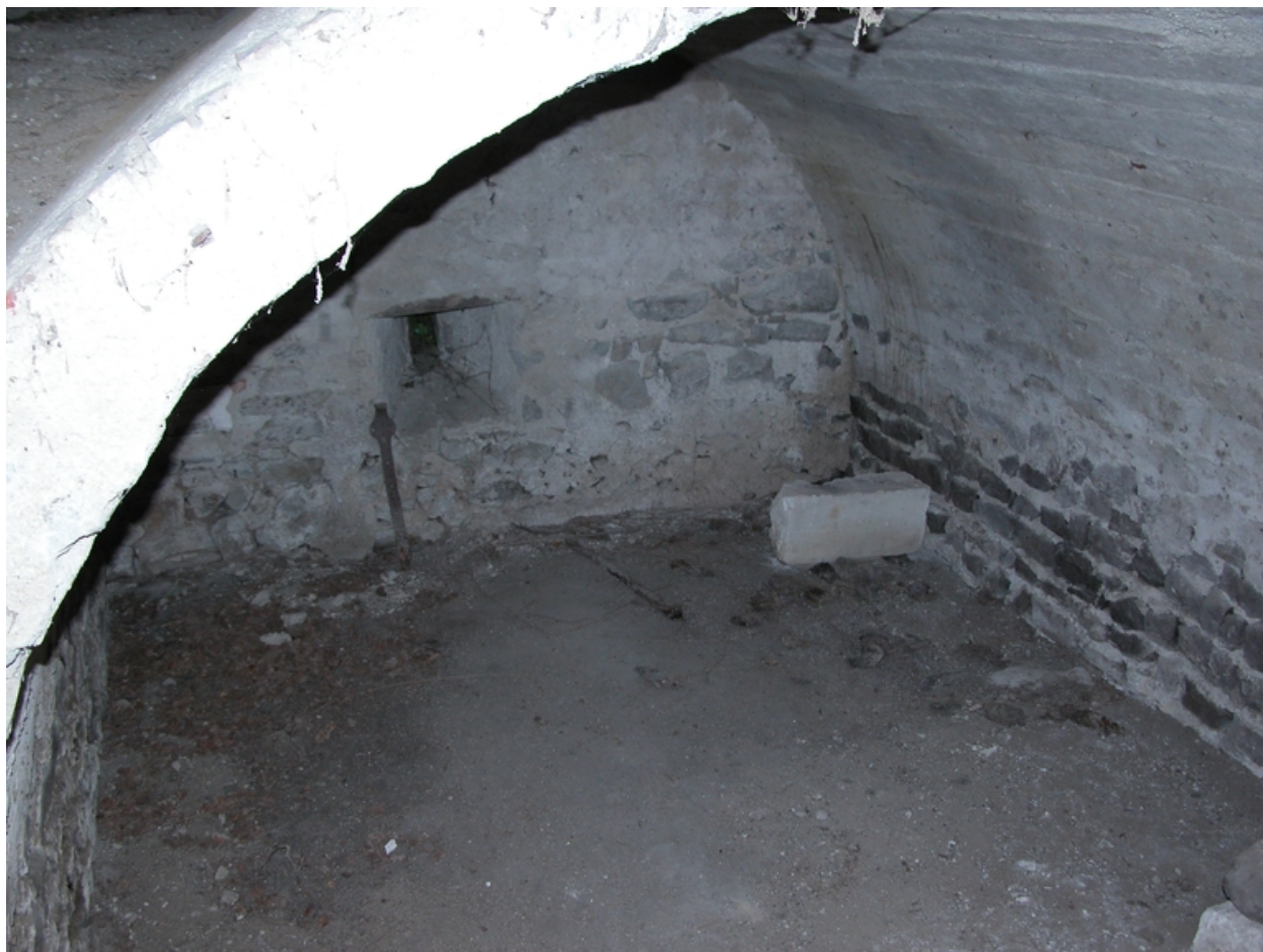
Vue intérieure du rez-de-chaussée : cellier voûté.
