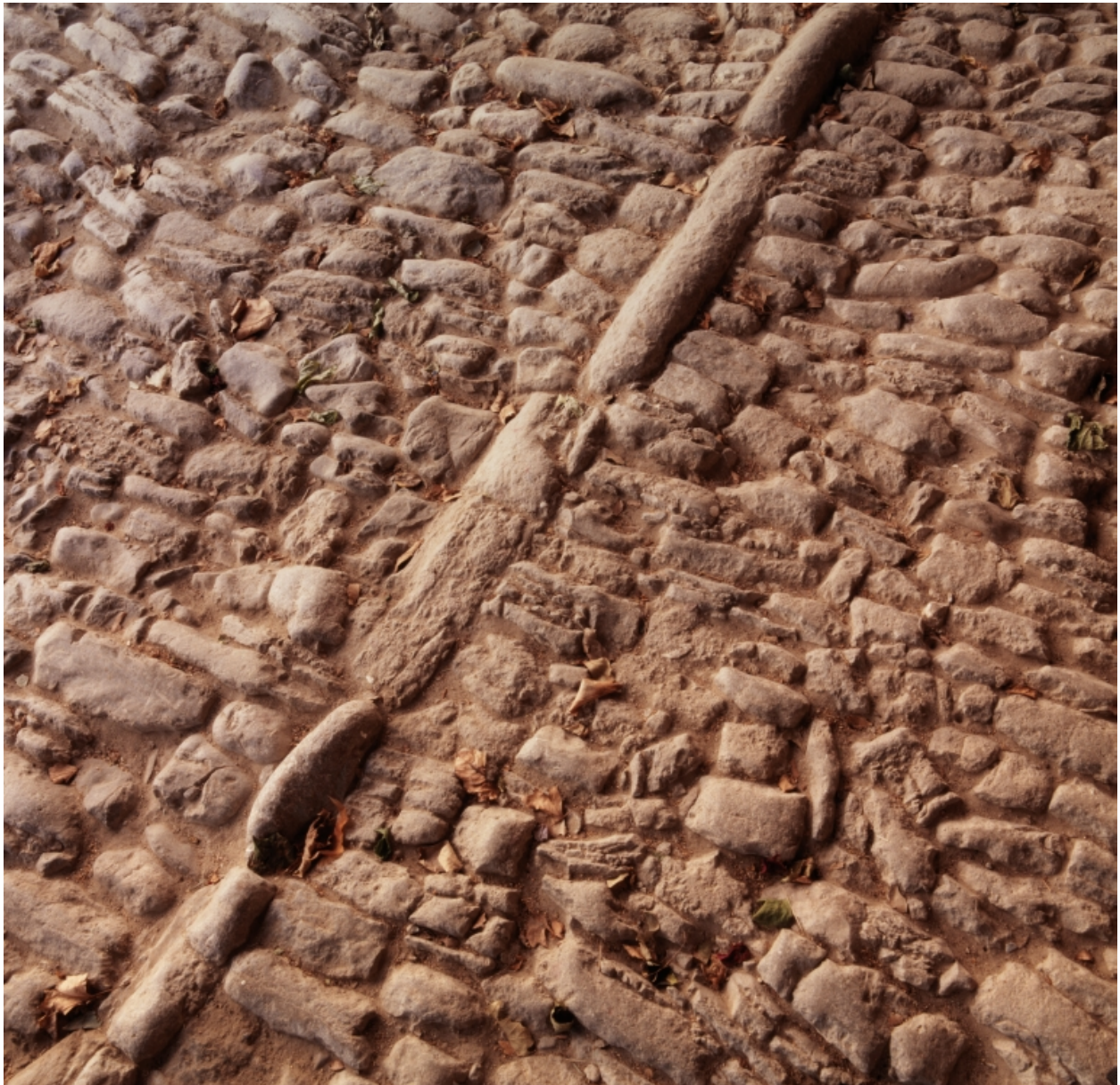
Détail du sol du hangar et de la remise en « calade » (moellons et galets).
