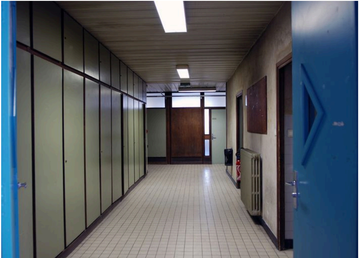
Bâtiment ISARA (2nd tranche), couloir du 2e étage
