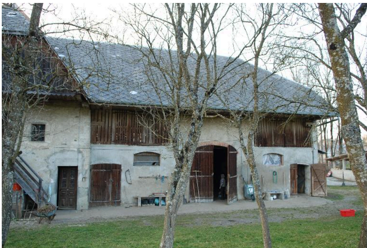
Vue d'ensemble de l'élévation principale des communs.
