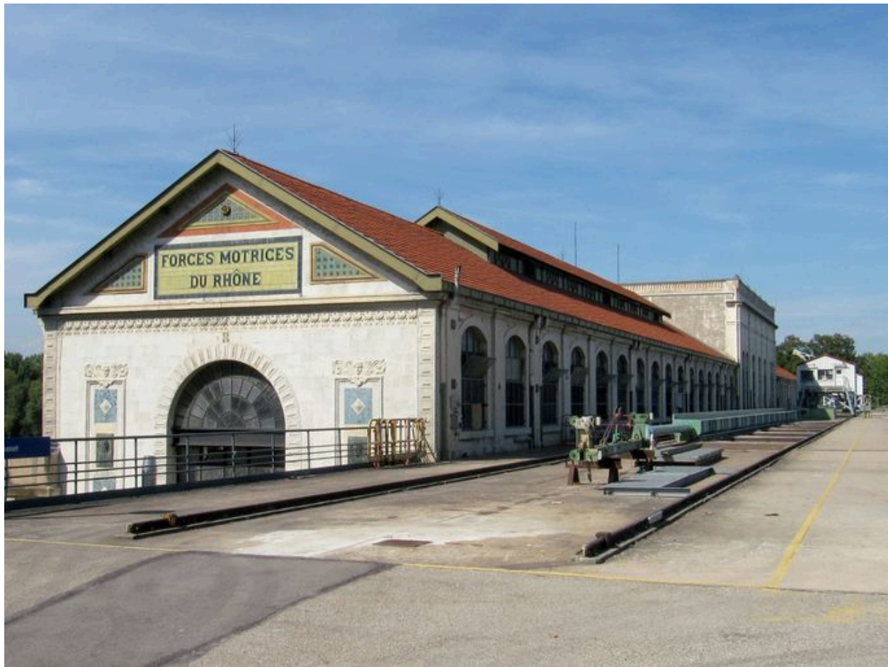
Vue des bâtiments, face amont (depuis la rive gauche)
