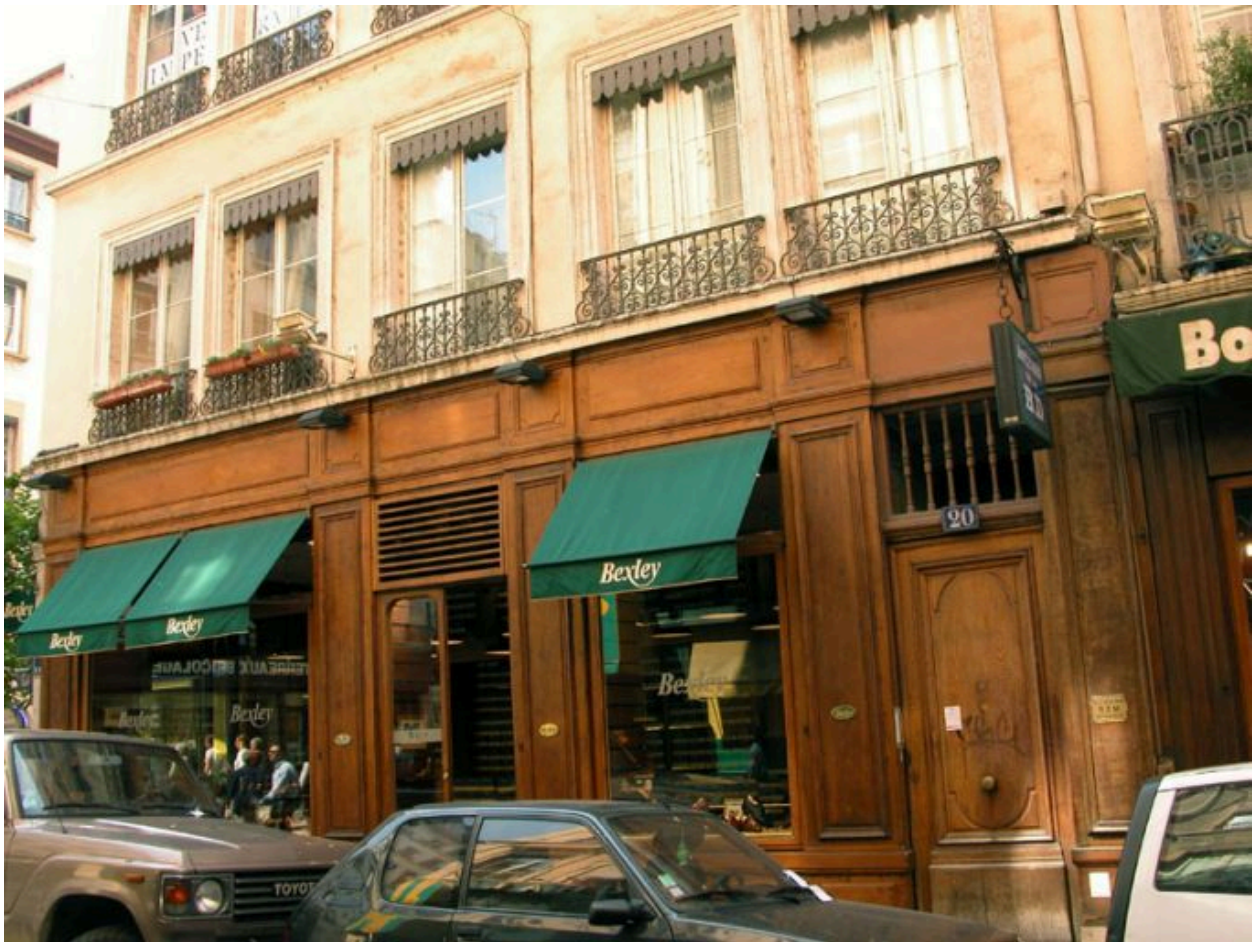
Immeuble commencé en 1858, façade sur rue, détail du 1er niveau
