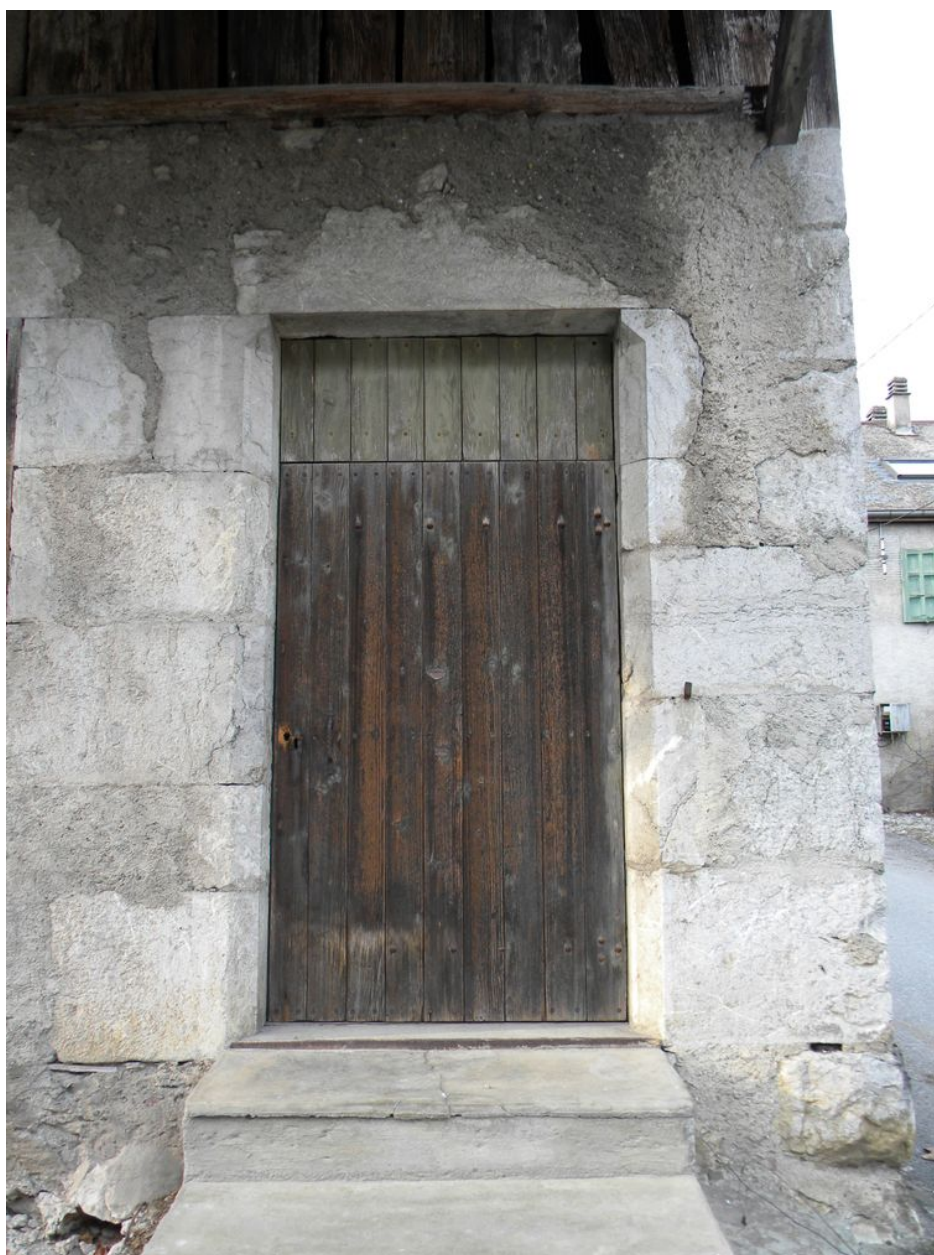
Encadrement de porte chanfreiné, façade arrière de la dépendance agricole sud.
