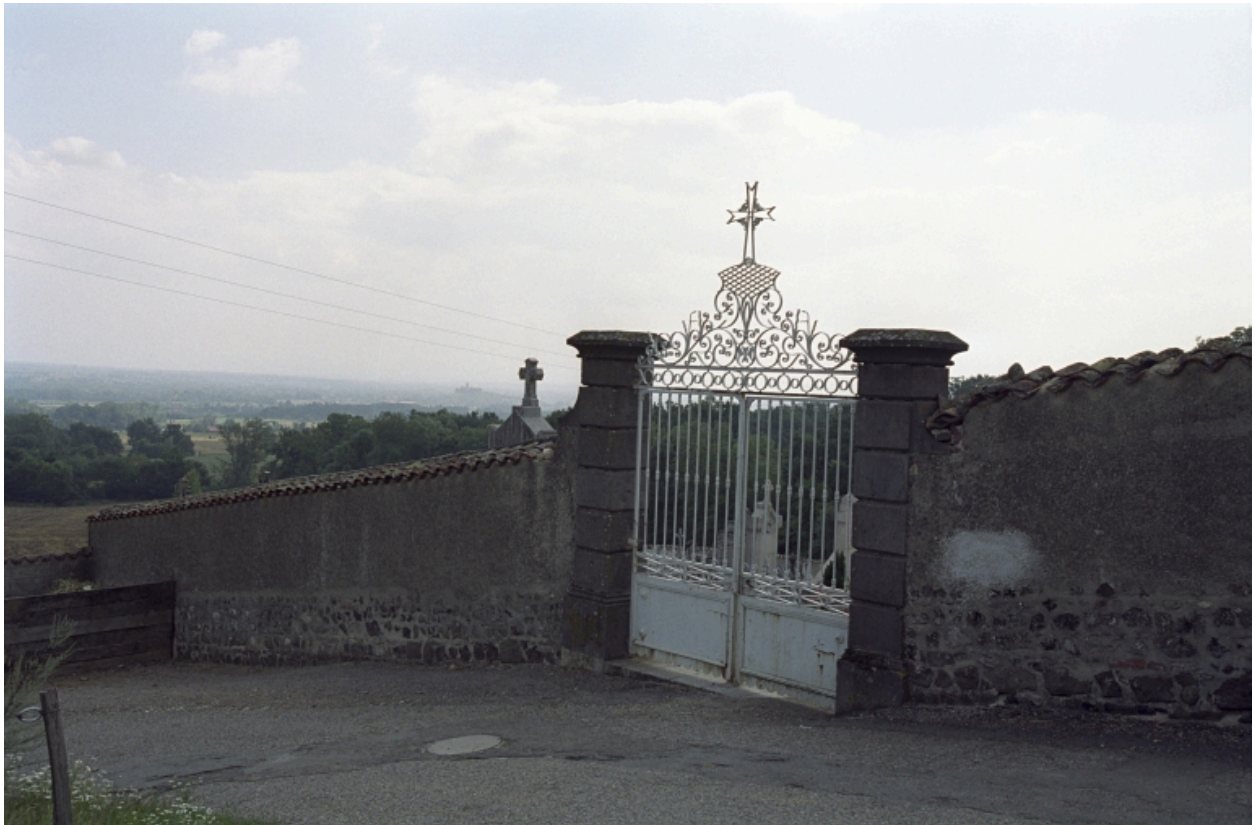
Vue d'ensemble du portail.
