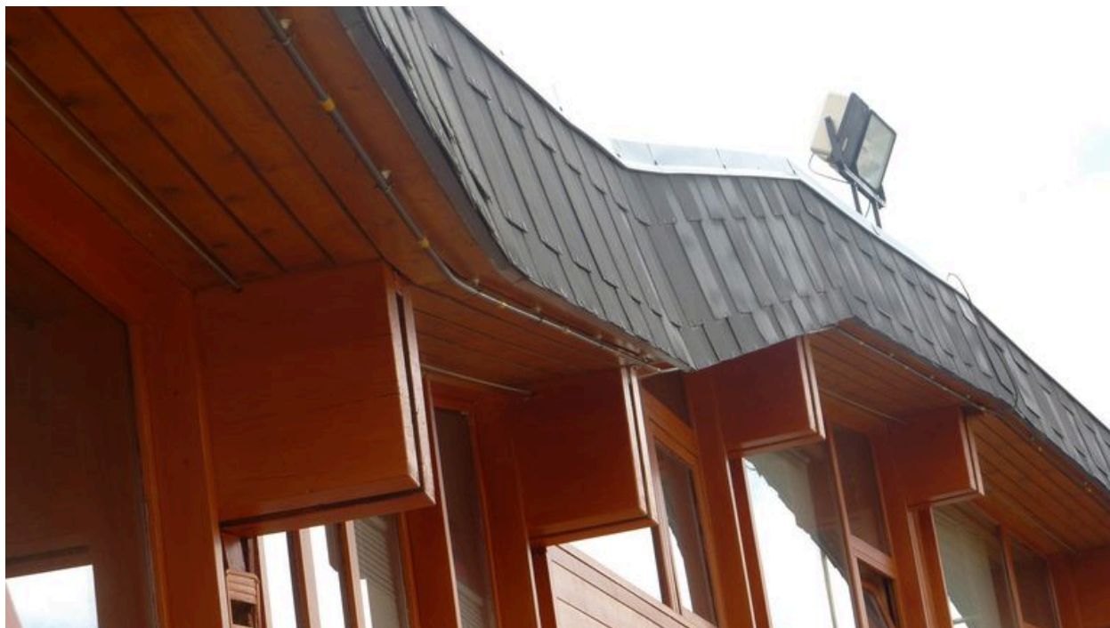
Détail de la corniche
