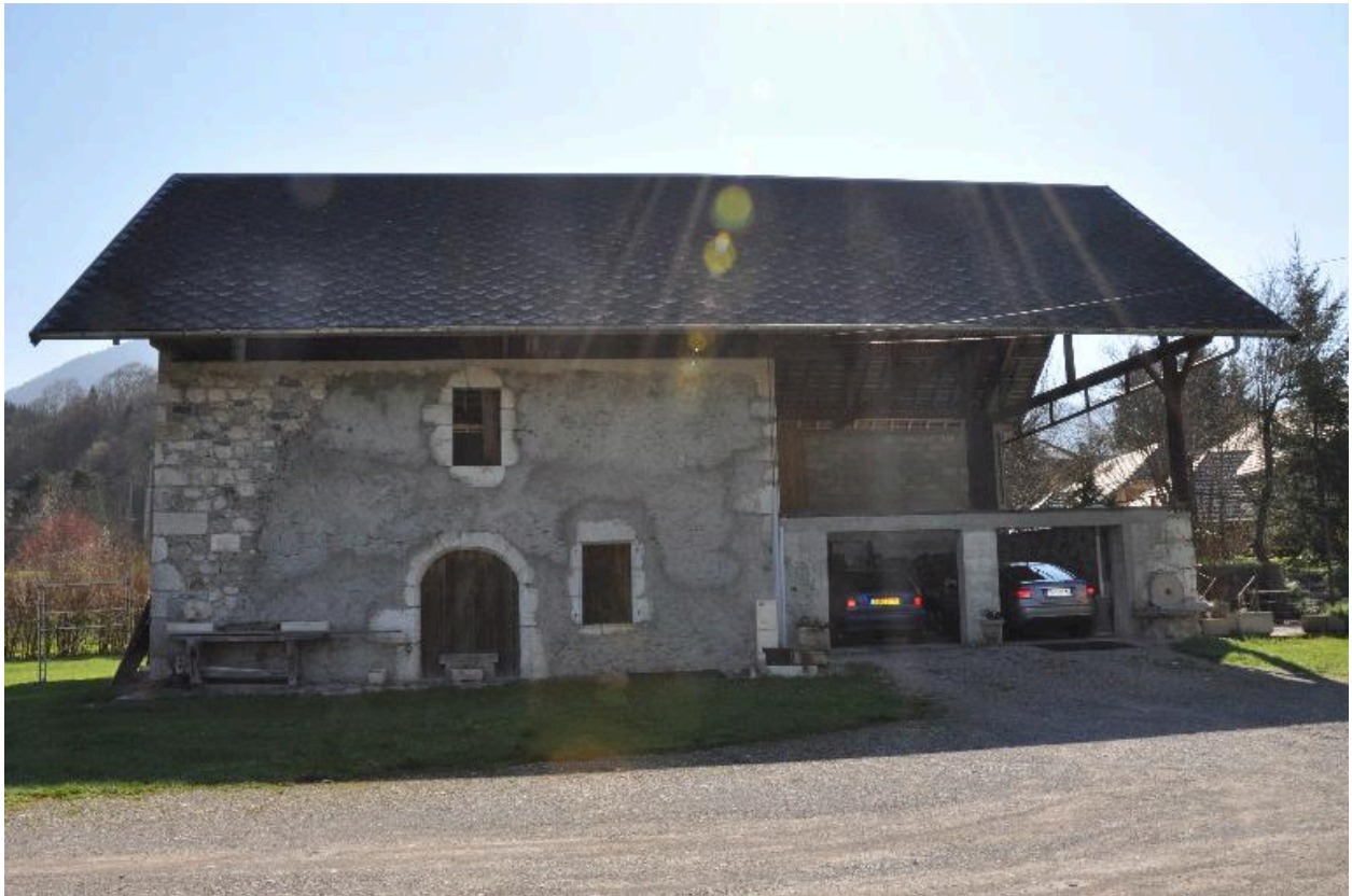
Vue du moulin amont.
