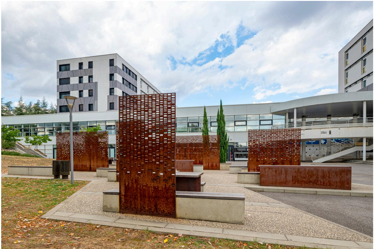
Entre : vue de face.
