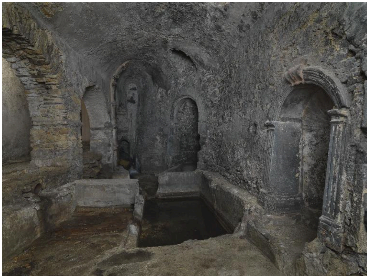
Sous-sol de l'aile des cuisines : vue générale des bassins et fontaines, depuis l'ouest
