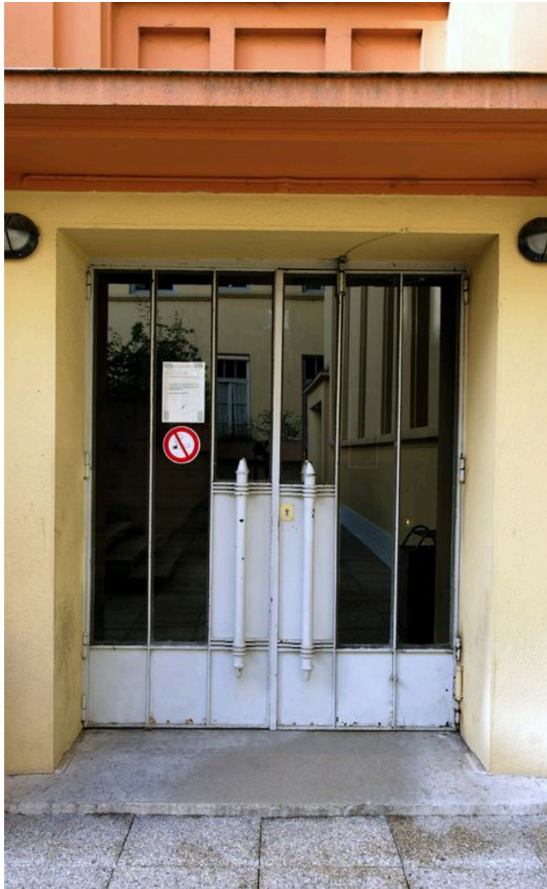
Cour intérieure, élévation latérale est (bâtiment Leperc), détail : porte d'accès à l'escalier.
