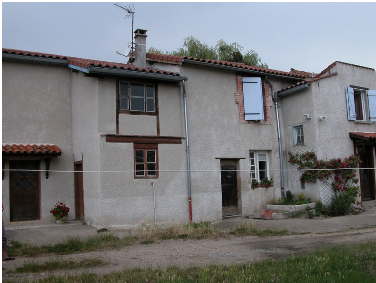
Vue du logis et du logement de la ferme ouest, depuis le sud-est.
