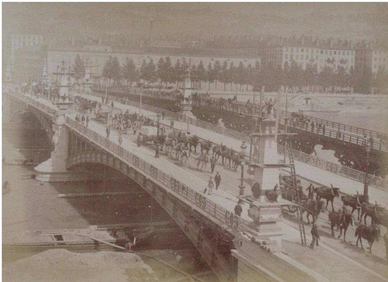
[Construction du pont du Midi : 2e épreuve du pont par poids roulant] / Fabrègue et Tardy phot., [juillet 1891]. 1 fotogr. pos. : n. et b. (AM Lyon. 2 Ph 00278, n°35)
