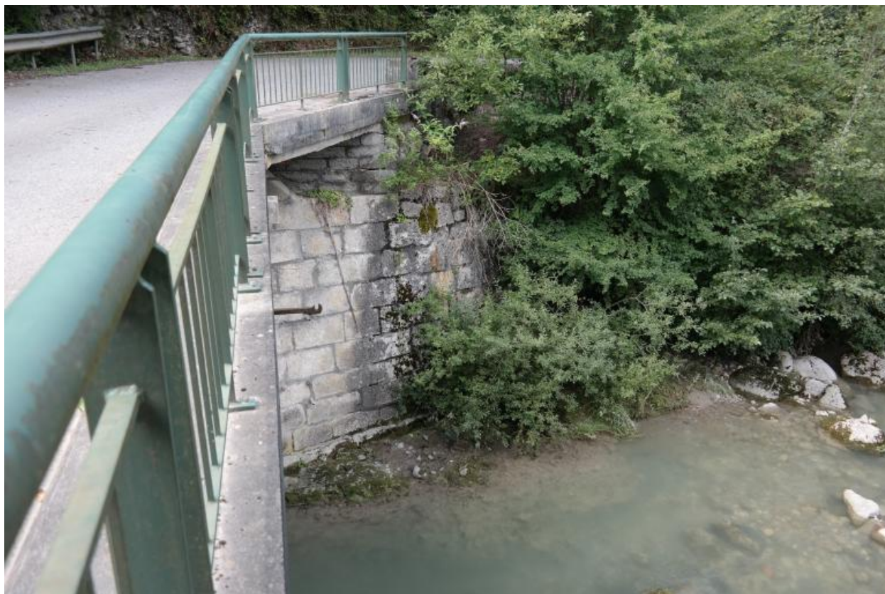
Pont de Bioge, vue de la face amont
