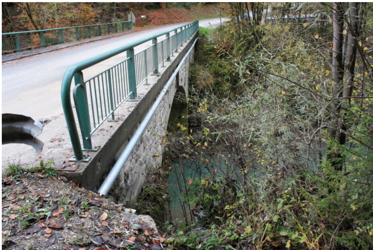
Pont de la Forclaz, détails gardes corps et plinthes
