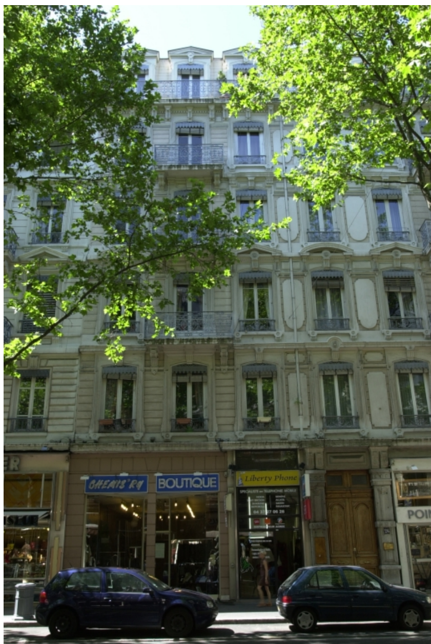
Elévation principale, vue partielle
