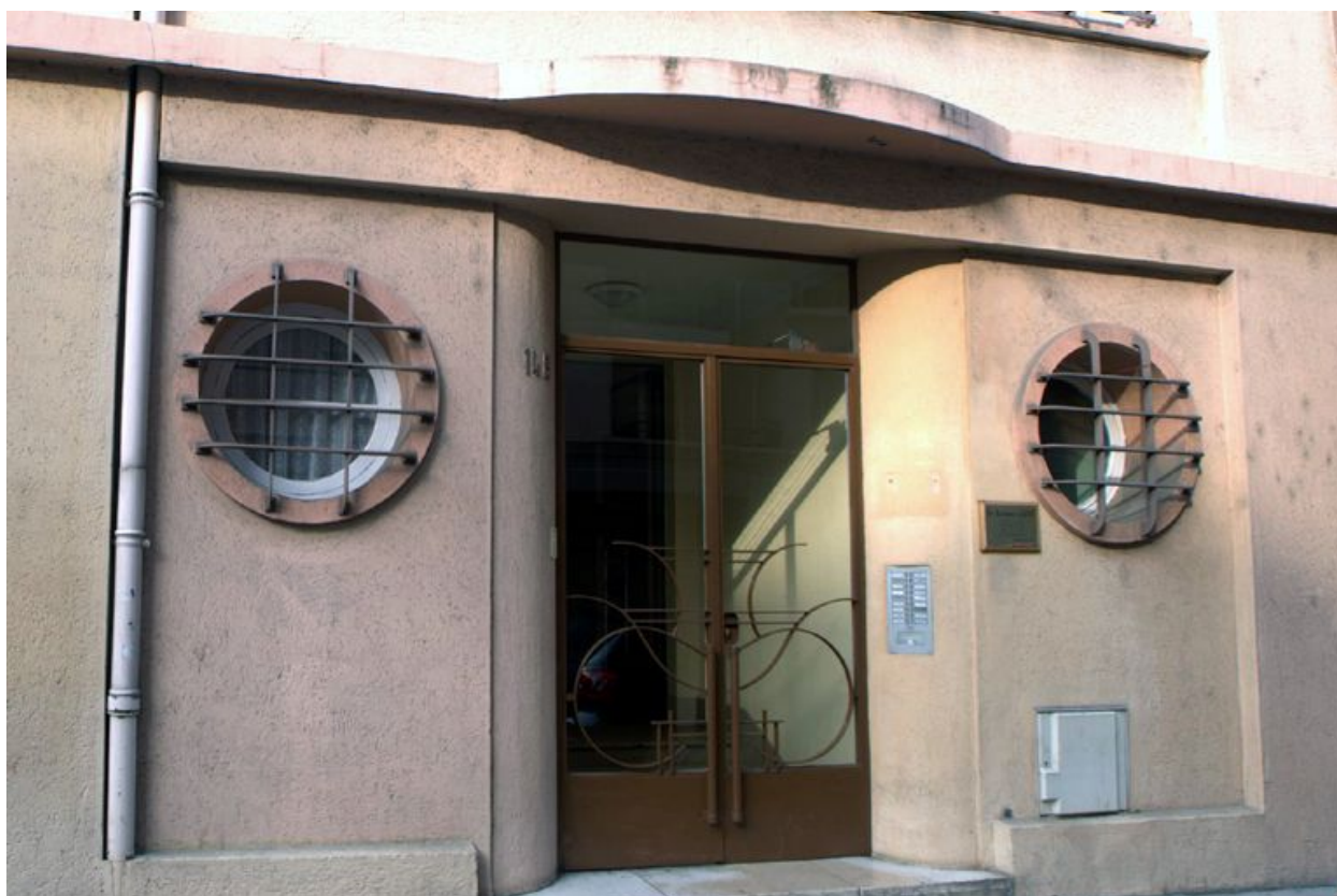
Elévation principale, détail de l'entrée
