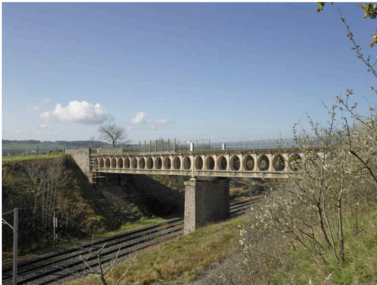
Le pont routier de Randan, vu de trois-quarts.
