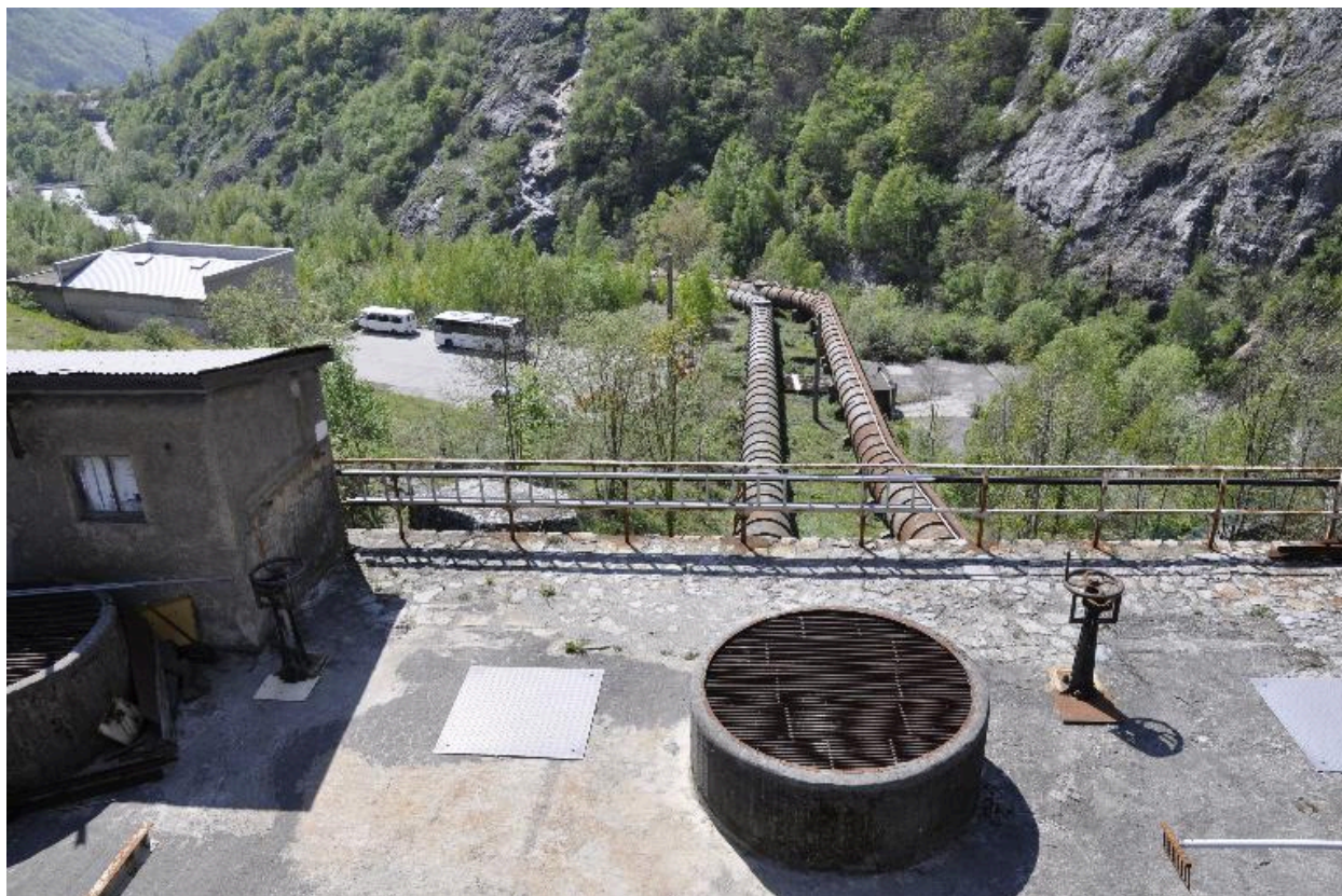
Vue des conduites forcées du barrage
