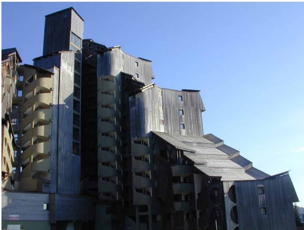
Vue depuis le nord-est : les cages d'escaliers
