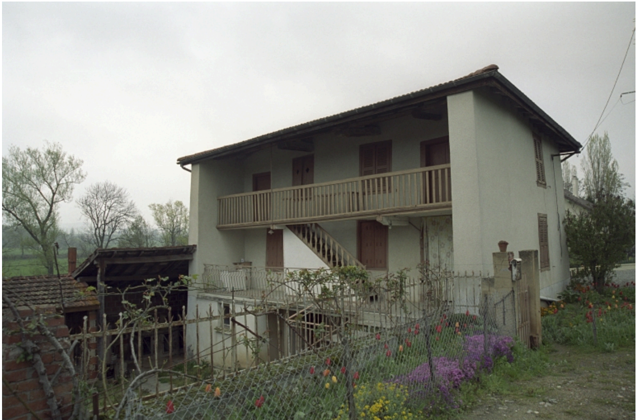
Bussy-Albieux, le bourg (1987 A1 341, 342), type C2. Vue d'ensemble du logis.
