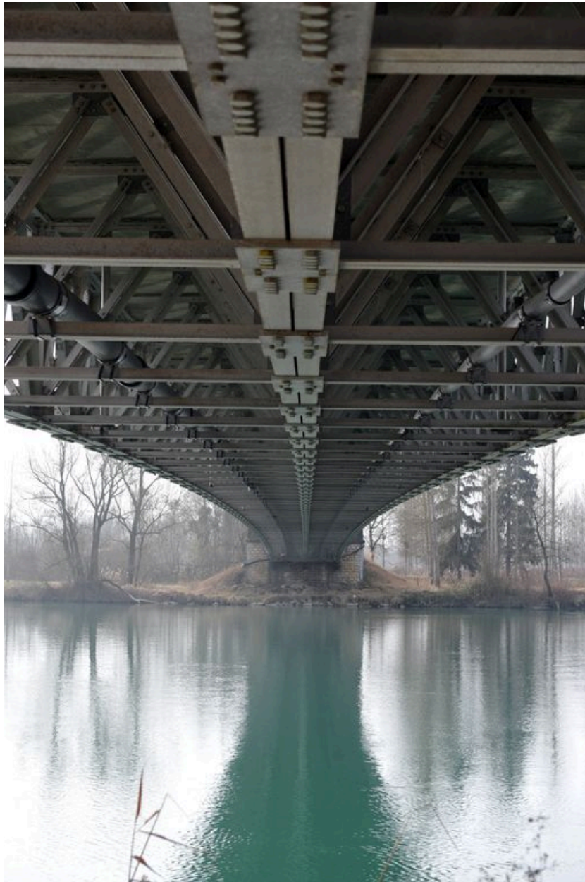
Vue générale, de dessous, tablier (depuis la rive droite)
