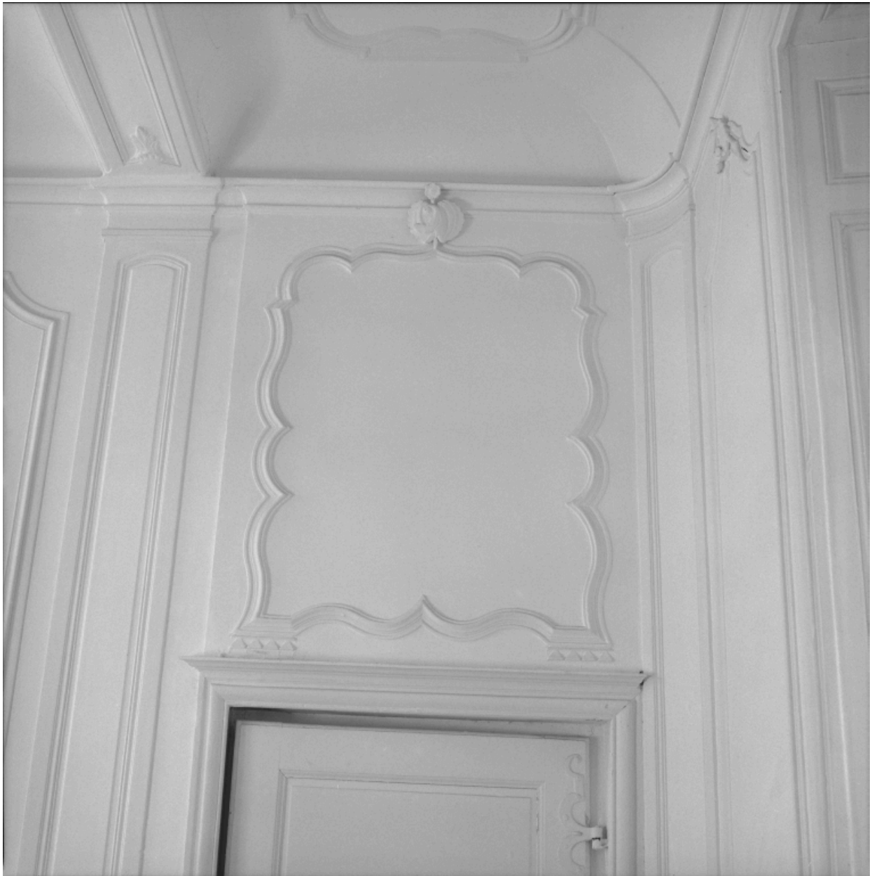
Détail d'un lambris au-dessus de la porte d'entrée de la 2e chambre du rez-de-chaussée.
