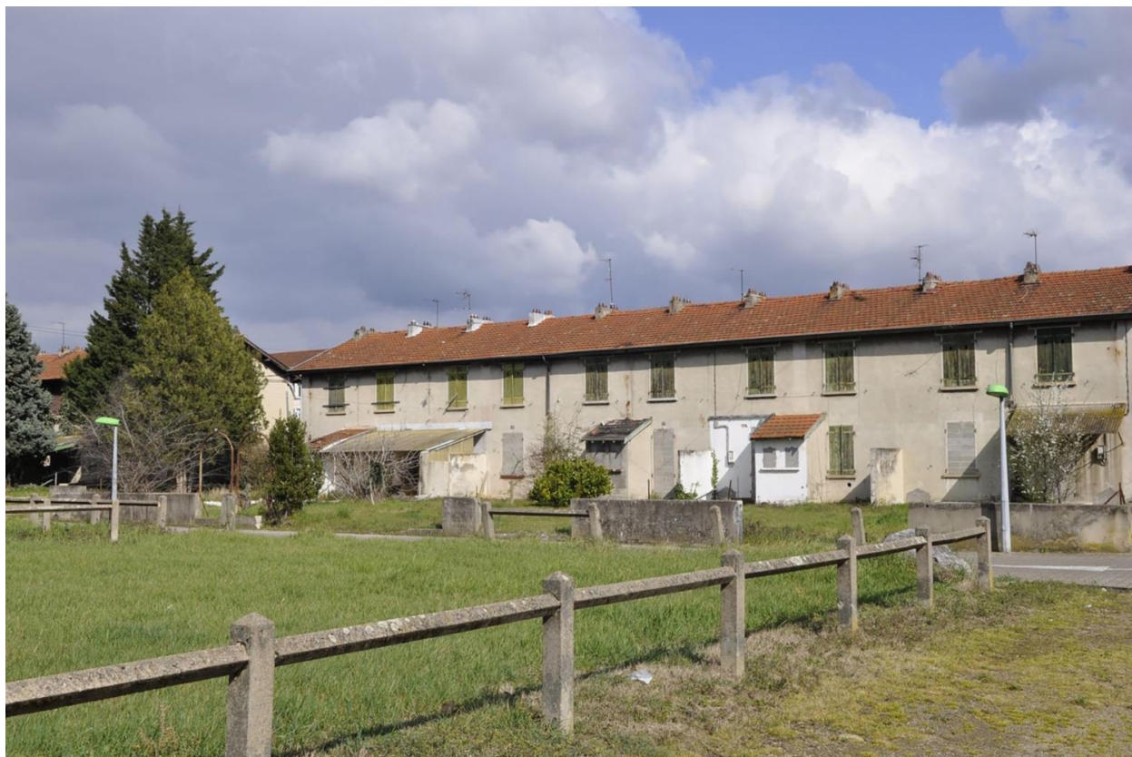
Ancien logement caserne (qui vont être démolis)
