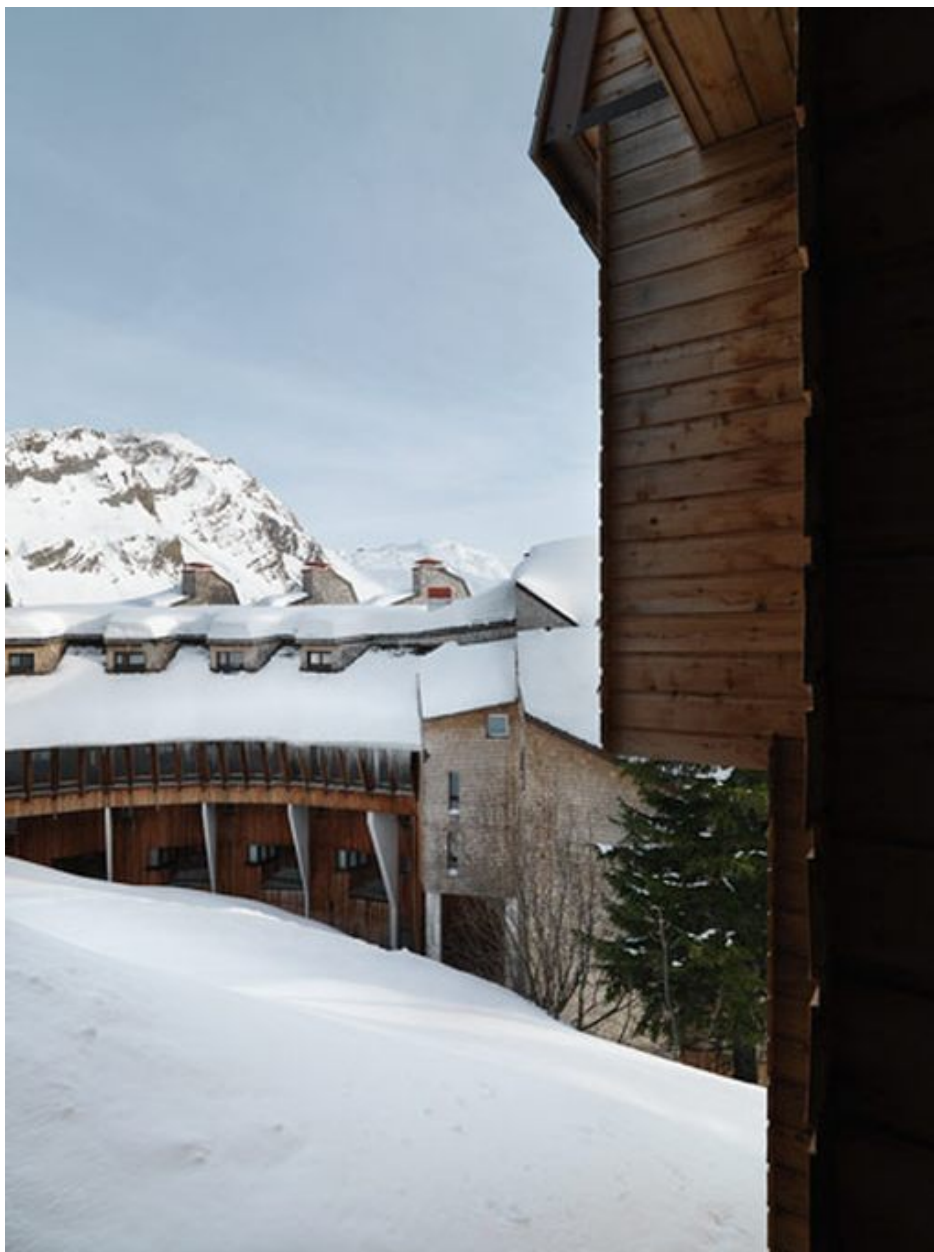
Détail de la galerie en encorbellement
