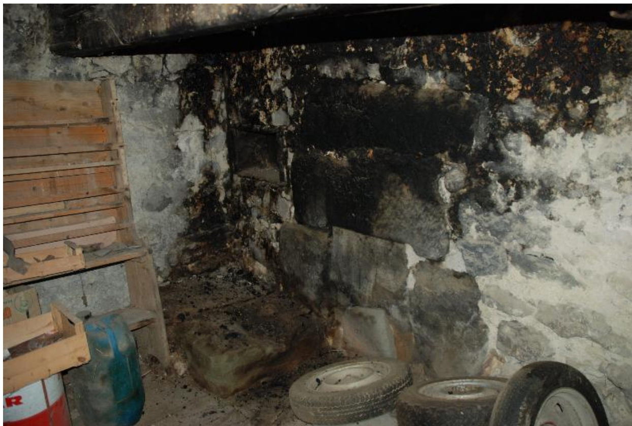
Vue du foyer de la cheminée.
