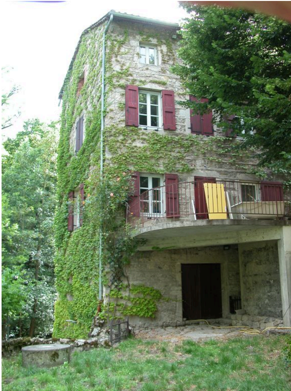
Façade ouest du moulin, élévation de gauche.
