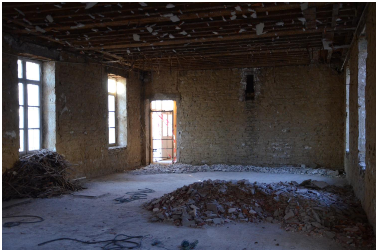
Petit lycée : intérieur en cours de travaux, v. 1996 (Phot. M. Poncin, A Lycée Lalande)
