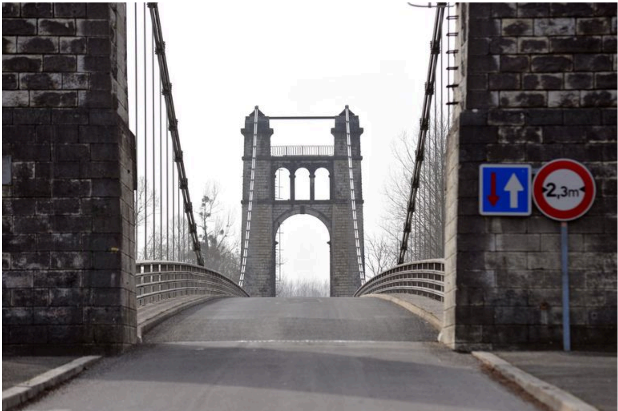
Vue partielle, de dessus, chaussée et pylône gauche (depuis la rive droite)
