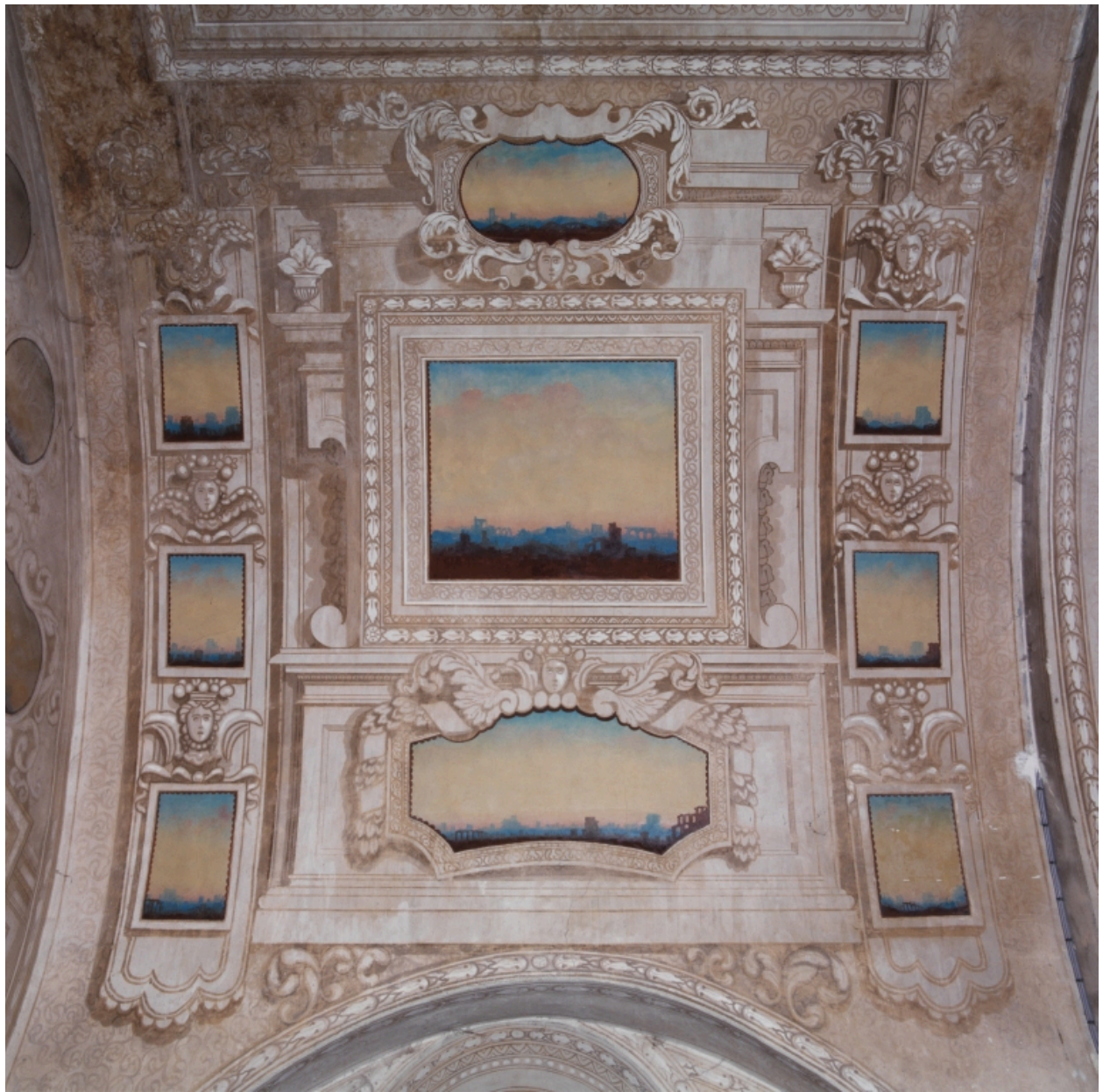
Vue partielle de la voûte.
