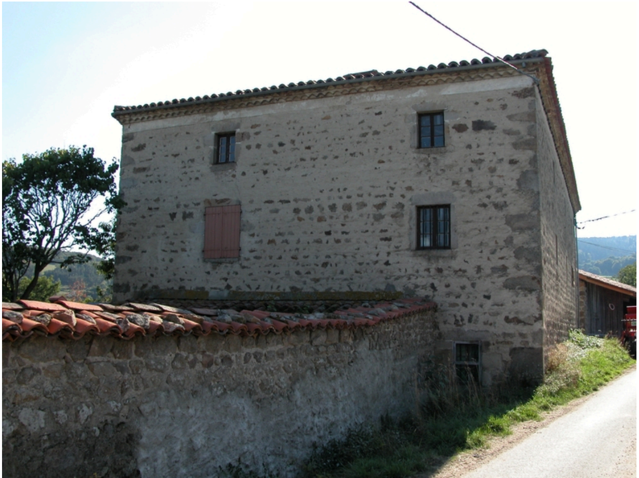
Vue du logis de trois-quarts, depuis le nord.
