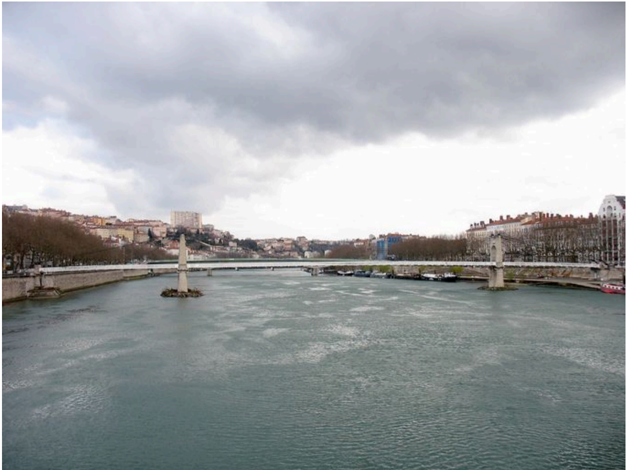
Vue de la passerelle dans le site, côté aval (sud)
