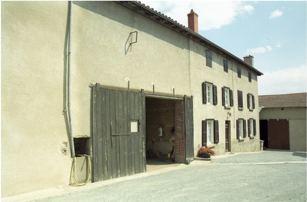
Vue d'ensemble d'une ferme (A2 620, 622, 623) depuis la cour.
