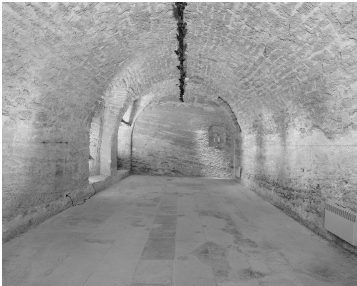
Grande cave. Vue générale vers le nord.
