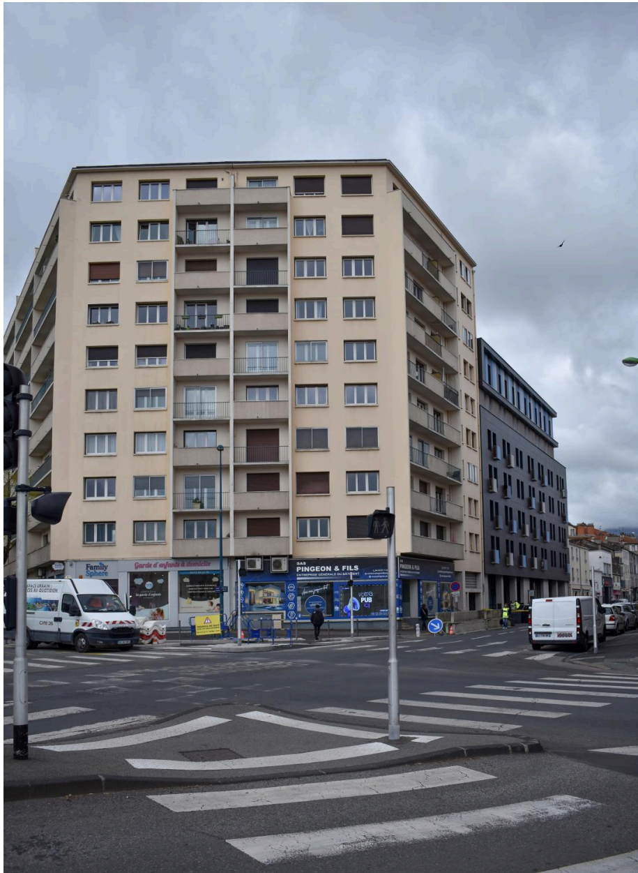
Façade sur le carrefour des boulevards Lafayette et Cote-Blatin
